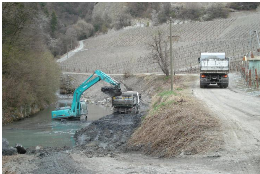
Figure 7- Exemple d'un curage mécanique en eau dans un cours d'eau (DEC)
